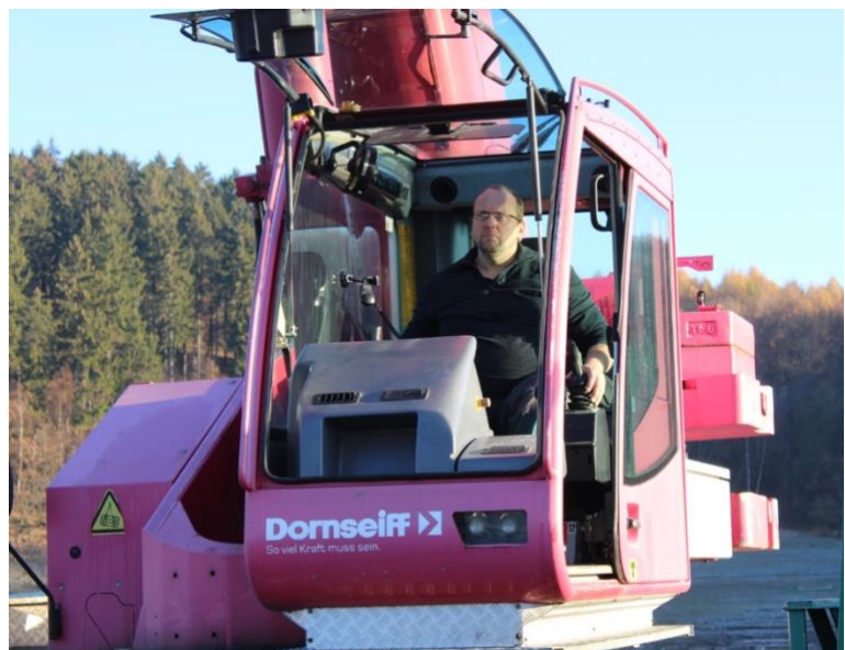
Der Kranführer ist hochkonzentriert bei der Arbeit, Quelle YCL
